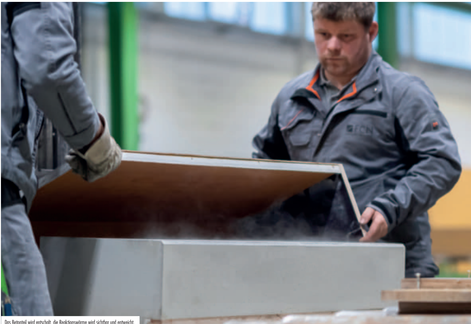
Das Betonteil wird entschalt, die Reaktionswärme wird sichtbar und entweicht.
