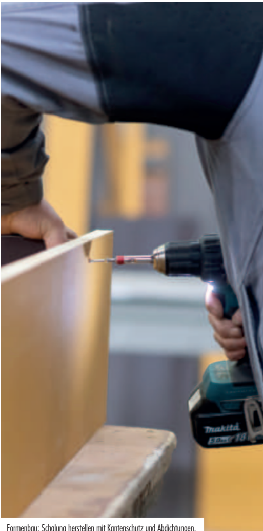
Formenbau: Schalung herstellen mit Kantenschutz und Abdichtungen.
