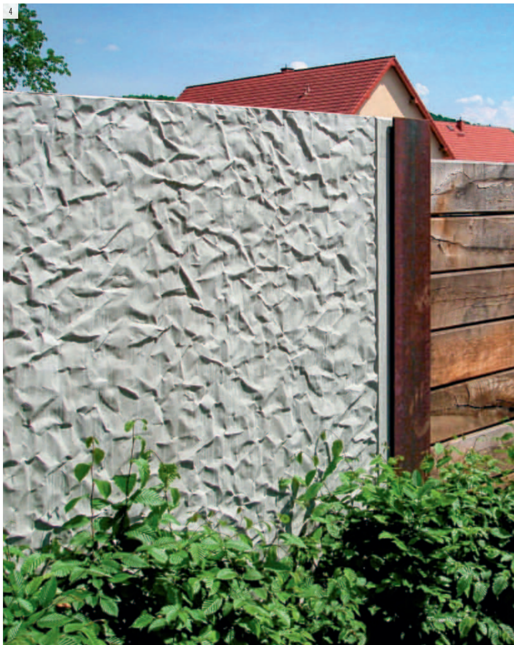
1 | Betonstele | Oberfläche gestrahlt | graphitgrau (uni) 2-4 | Sichtschutz Reckli-Struktur Gironde 2/151 (Maßanfertigung) | Oberfläche unbearbeitet | grau (uni)
