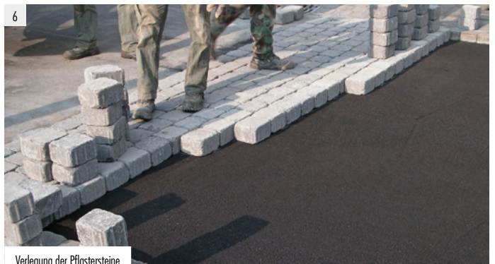
Verlegung der Pflastersteine
