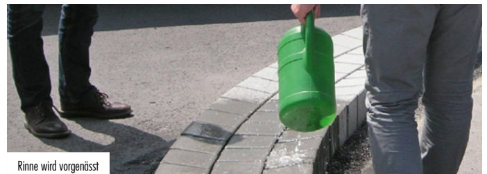
Rinne wird vorgewässert
