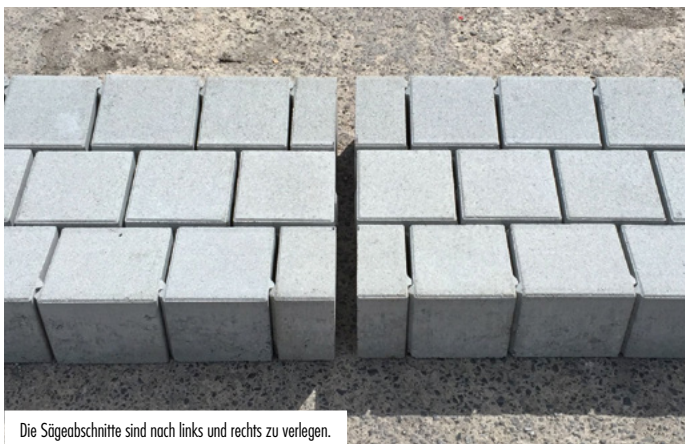
Beim Anlegen einer Bewegungsfuge sind zwei Normalsteine zu sägen.
