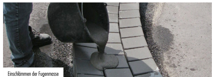
Einschlämmen der Fugenmasse
