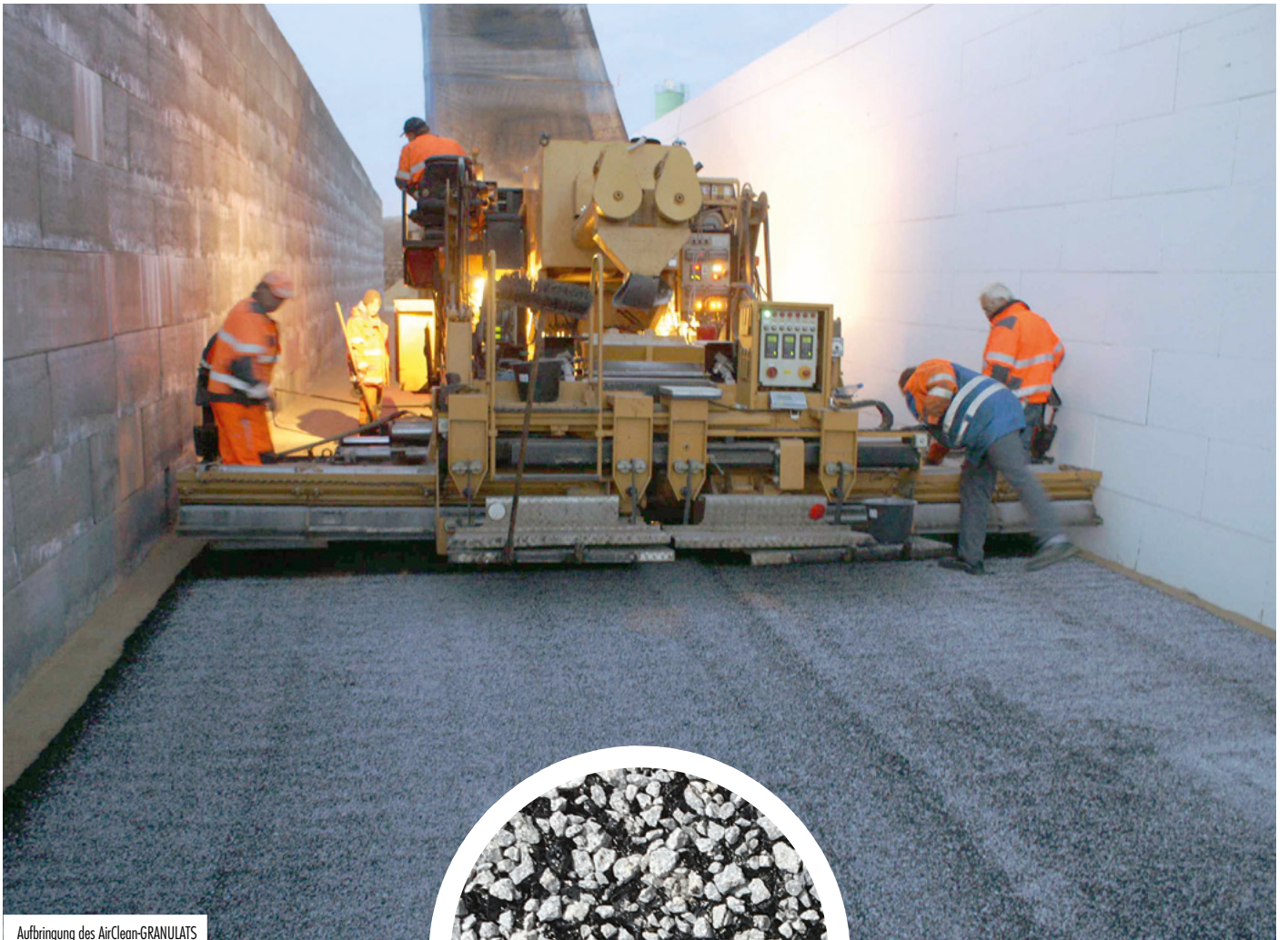
Aufbringung des AirClean-GRANULATS
