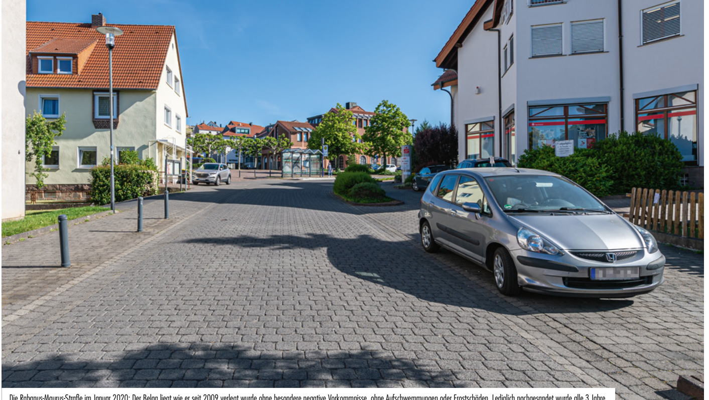
Die Rabanus-Maurus-Straße im Januar 2020: Der Belag liegt wie er seit 2009 verlegt wurde ohne besondere negative Vorkommnisse, ohne Aufschwemmungen oder Frostschäden. Lediglich nachgesandet wurde alle 3 Jahre.
