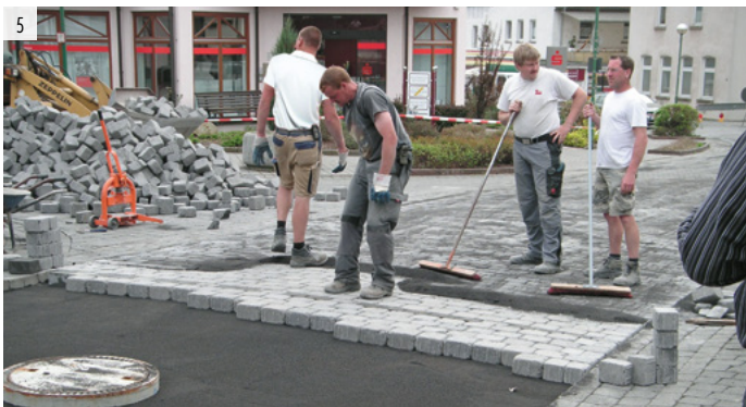
Verlegung der Pflastersteine
