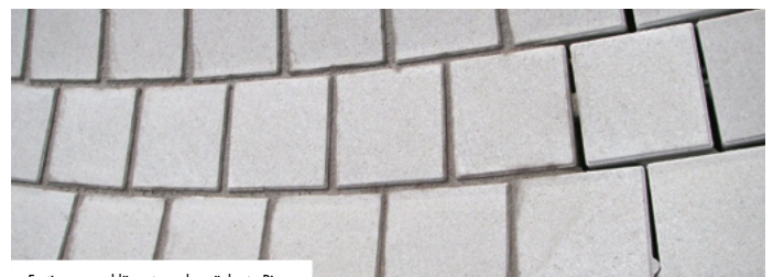
Fertig ausgeschlammte und gesäuberte Rinne
