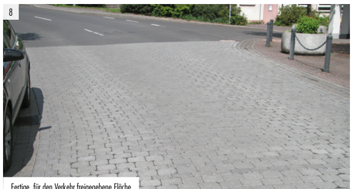
Fertige, für den Verkehr freigegebene Fläche
