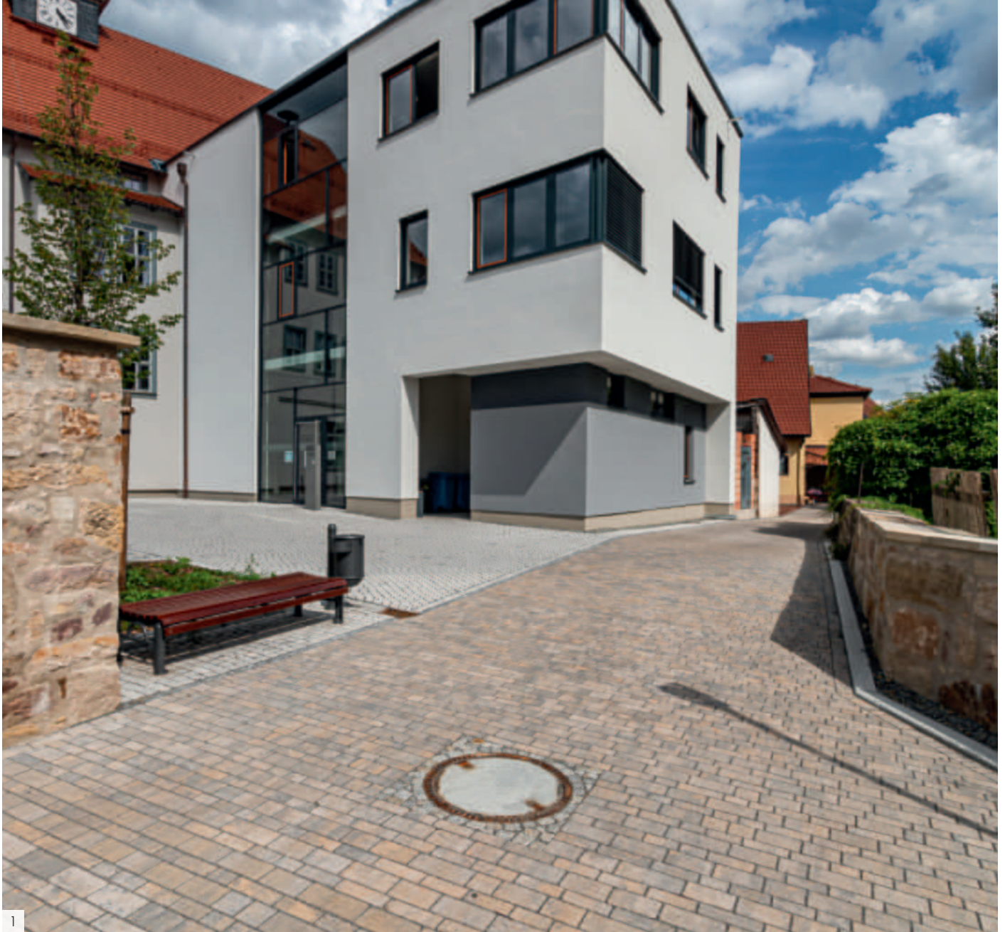
1-2 | Mehrformat 9-Stein-System | kalk | V427 - wilder Reihenverband
