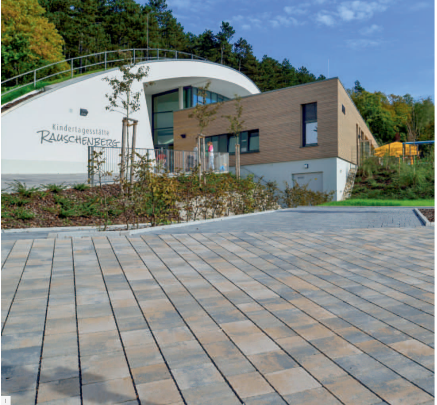
1-2 | Mehrformat 7-Stein-System | kalk | V428 - wilder Reihenverband
